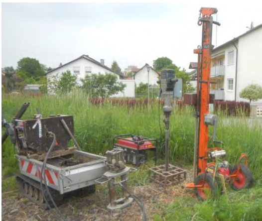
Transportraupe mit Hydraulikaggregat für hydraulisches Ziehgerät, Stromaggregat, Elektrohammer, Lindenmeyer Rammsondiergerät
